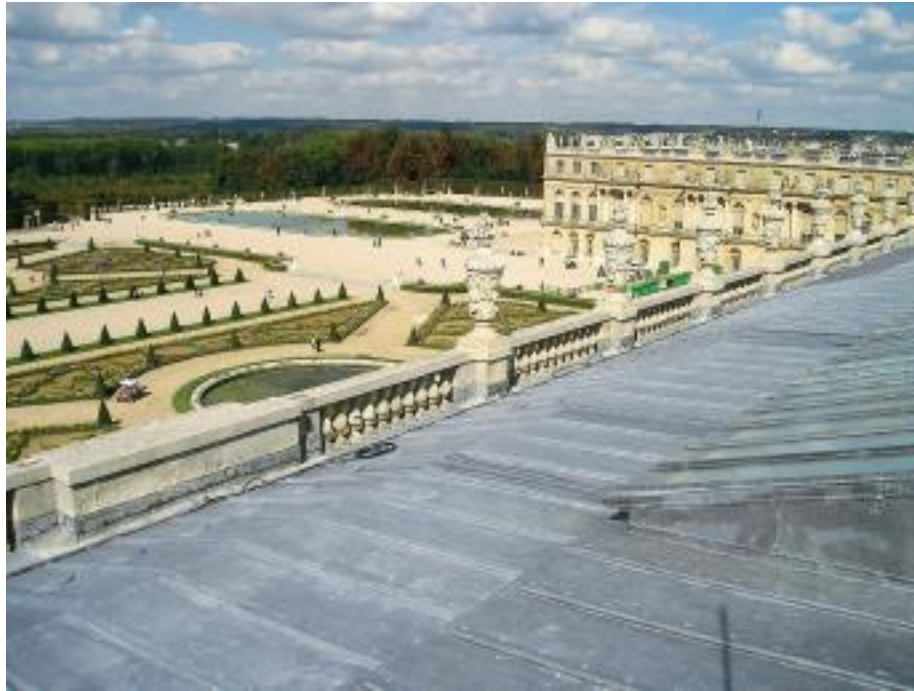
Implementation: Château de Versailles-Aile du midi-2004 150 tonnes of SMH lead
